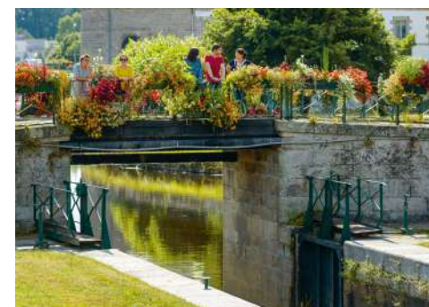
Écluse fleurie sur la rivière Blavet.
